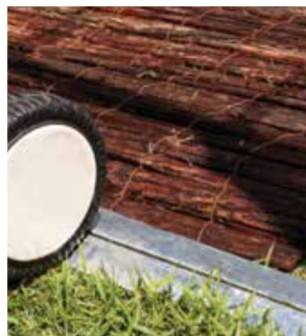
Süllyesztett a talapzata a kerekek könnyebb áthaladásához.
