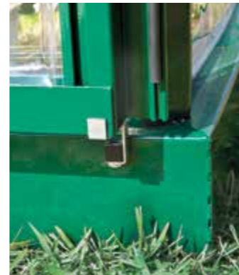
Mágneszáras a reteszelés a nyitott ajtónál.
