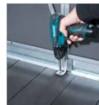
Horganyzott acél talapzat
