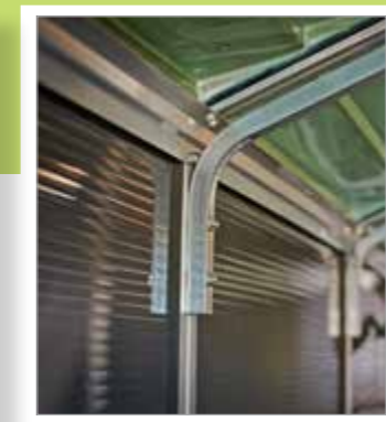
Kiegészítő fém merevítők az extra stabilitásért
