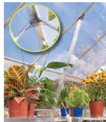
Speciálisan merevített a konstrukció.
